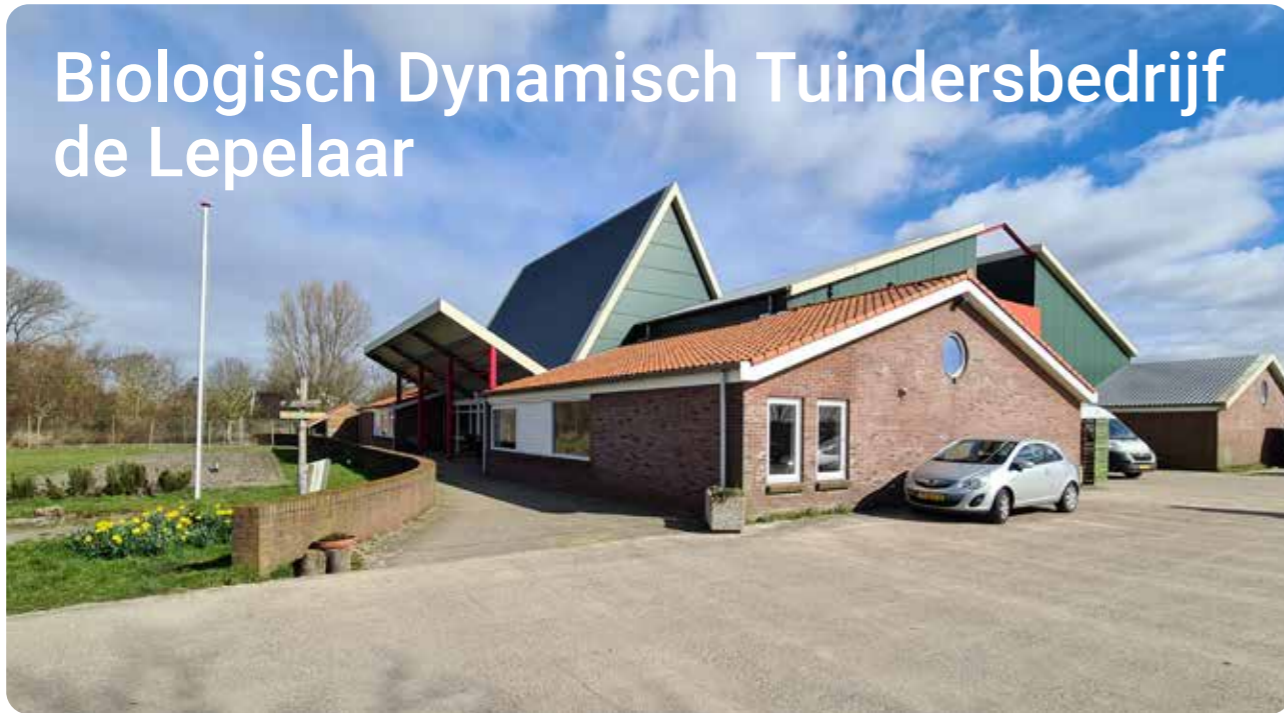
Schuuresemble met winkel in post-moderne architectuurstijl
